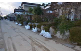
液状化が発生した路地
