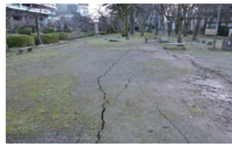
城址公園内の亀裂と噴砂跡
