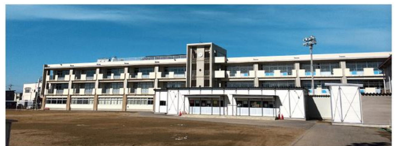
藤ノ木小学校耐震化工事中
